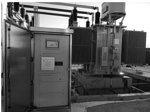
图1 高电压设备在线监测装置
